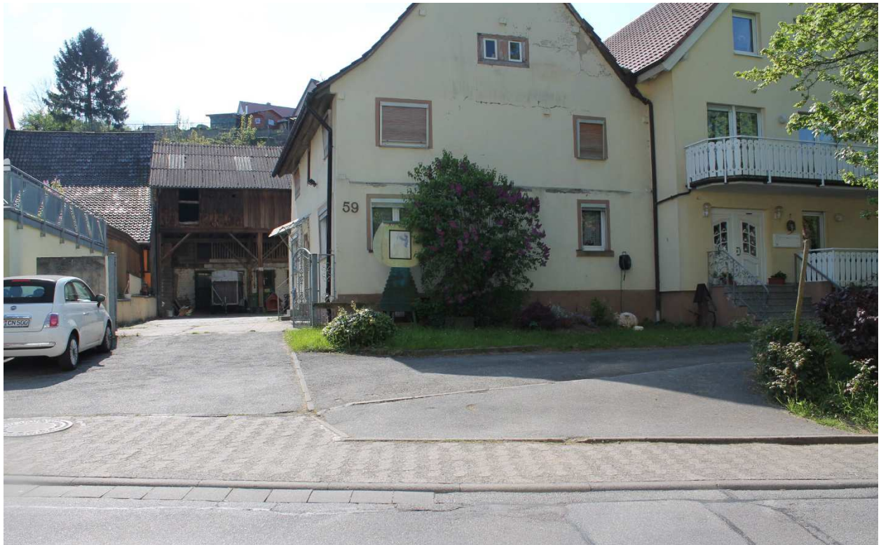
Abb. 2: Einfahrtssituation über die Hambacher Talstraße
